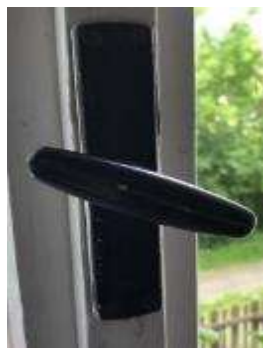
tento typ okenní olivy bude v plném rozsahu vyměněn za nový v provedení mosaz
