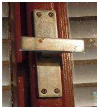
tento typ okenní olivy bude v plném rozsahu vyměněn za nový v provedení mosaz
